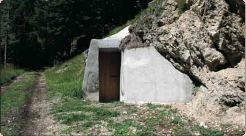
Casermetta prima di Col Da Daut ristrutturata.
